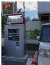
屋外設施照明
